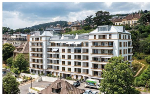
**RÉALISATION** > À l'extérieur, les façades protégées ont été nettoyées et repeintes, les balustrades réhaussées et les fenêtres changées. Mais l'isolation, vu la protection des façades, n'a pu se faire qu'à l'intérieur des murs. Au contraire de la façade nord, non protégée et en mauvais état, qui, elle, a pu être isolée de l'extérieur en respectant la modénature antérieure.
