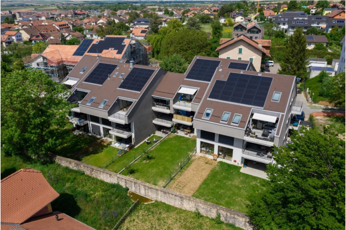
Résidence de la Chapelle, réalisation : 2018 – 2020 © SD Construction
