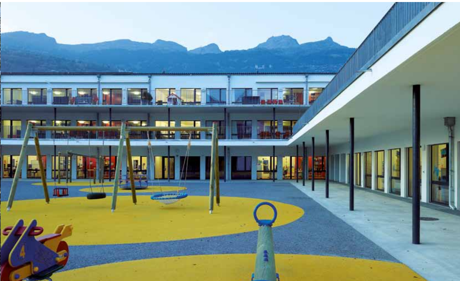
La cour de récréation traitée en terre d'agrégation et zones de jeux en tartan.
