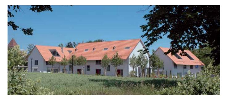
les doubles murs mitoyens étant réalisés en briques de terre cuite avec isolation phonique interstitielle. L'isolation thermique consiste en une enveloppe de polystyrène épaisse de 120 mm, appliquée extérieurement comme support au crépi de finition. Les vitrages, équipés de stores à lamelle et de verres isolants 1,1 W/m2K sont réalisés en bois/aluminium, et dotés ponctuellement d'ouvertures oscillo-battantes.
