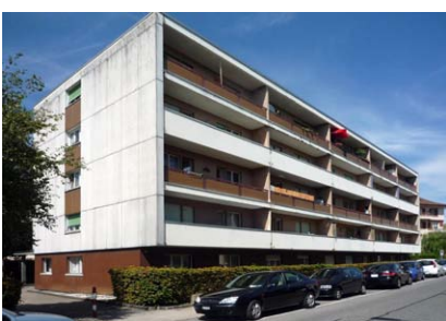
Photos avant travaux
